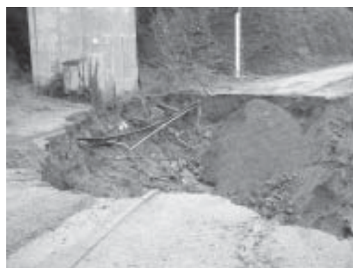
Diverses imatges de la urbanització Vall Repòs
