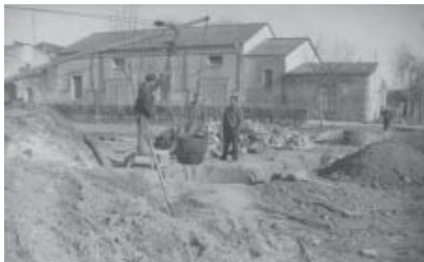
Preparació dels fonaments de l'edifici. Al fons l'antic cinema Balmaña
