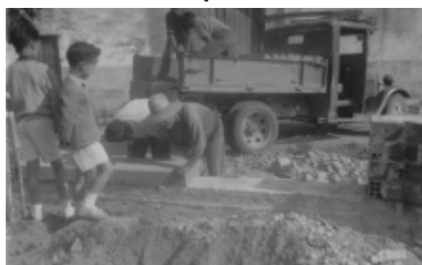
Nens mirant les obres a la banda del cinema Balmaña
