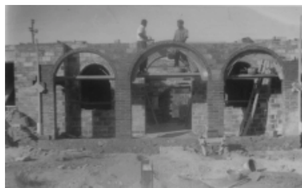
Les tres arcades de la façana principal
